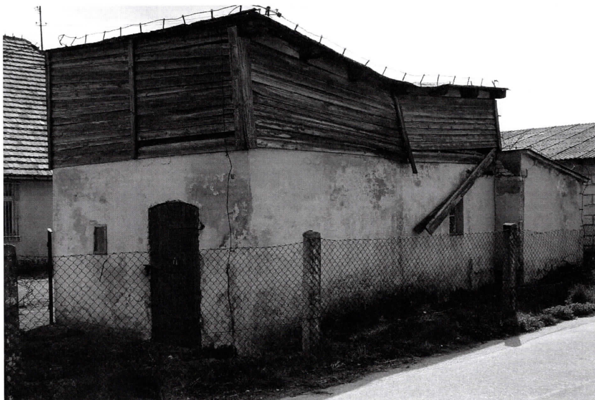
Zdjęcie 18. Obiekt budowlany przy b. posterunku Policji
